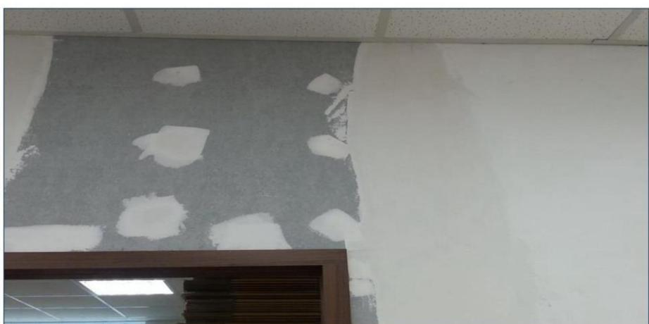
在貼合 No. 4075-50 單面不織布丁基橡膠防水膠帶，直接批土磨平。
