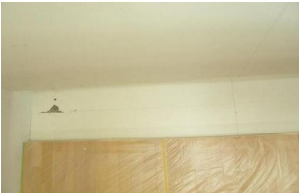
RC 柱拼砌磚加大產生龜裂，宜先拋除樑約 1 公分深，清潔後貼
