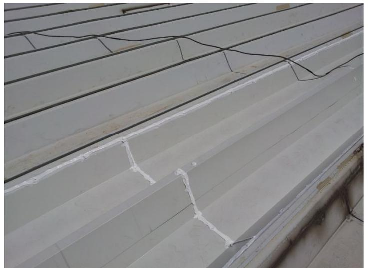
施工範例三：大園航空辦事處屋頂，玻璃採光罩與彩鋼搭接處黏貼丁基橡膠 No.503 系列防水雙面膠帶
